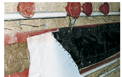
6. Weichstoffkompensator montieren und anschließend Stoßbereich nach Anleitung der Verklebanleitung verkleben (siehe Piktogramme).
