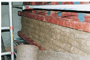
5. Mehrschichtige Vorisolierung gestopft einbringen.
