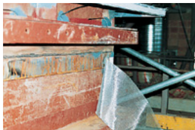
2. V4A-Drahtgewebe beidseitig abkanten ...
