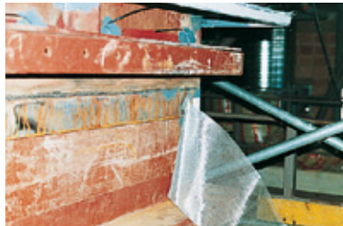
2. V4A-Drahtgewebe beidseitig abkanten ...
