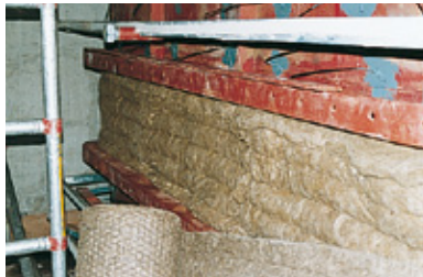
5. Mehrlagige Vorisolierung gestopft einbringen.
