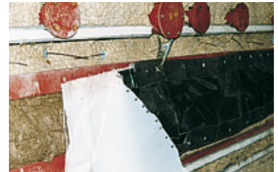
6. Weichstoffkompensator montieren und anschließend Stoßbereich nach Anleitung der Verklebeanleitung verkleben (siehe Piktogramme).
