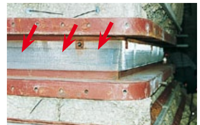
3. ... et d'un côté prévoir une fixation.
