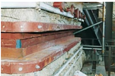
1. Vérifier les dimensions des supports métallique avant de commencer le montage du compensateur.
