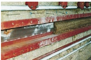
4. Mise en place de la laine minérale.
