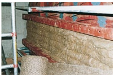
5. Bourrer de plusieurs couches pour obtenir un matelas isolant.
