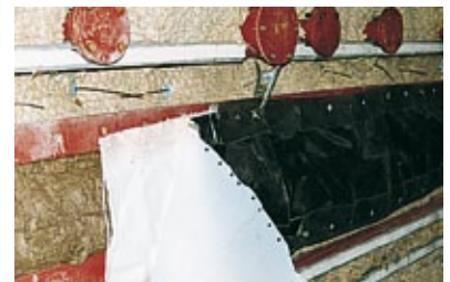
6. Faire le montage du compensateur et le fermer selon les instructions de collage (voir le pictogramme).
