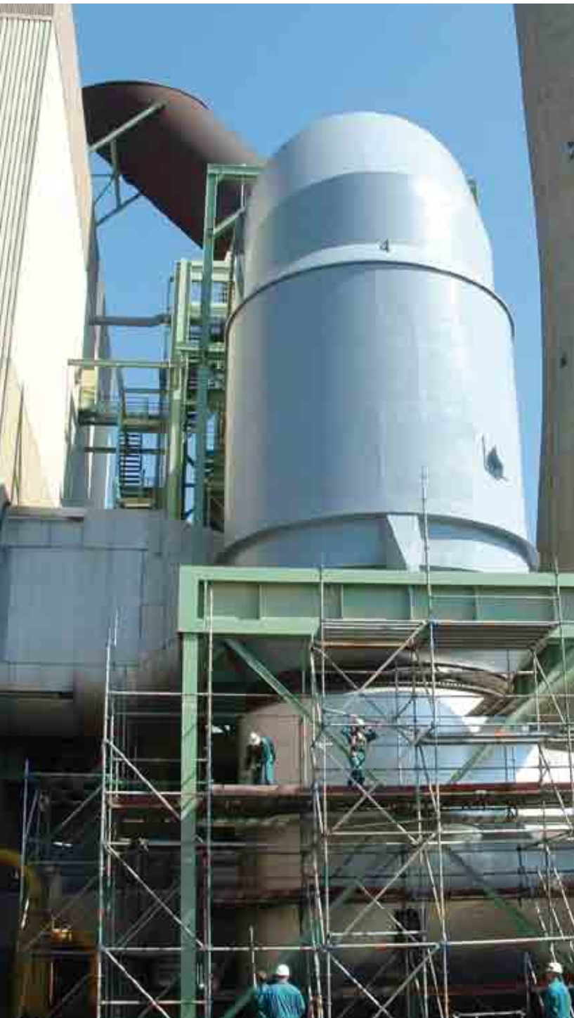
在一家水泥厂安装 KOREMA® 膨胀节
