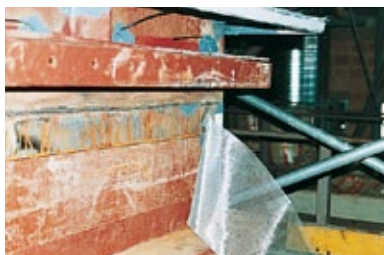
2. Gaas aan beide zijden afkanten ...
