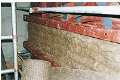
5. Meerlaagse voorisolatie gestopt inbrengen.
