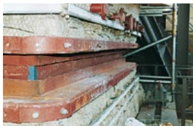
1. Staalconstructie zonder compensator. Opgelet! Vóór montagebegin de maten controleren!
