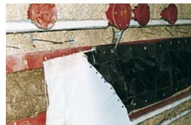
6. Zachte compensator monteren en daarna verbinding bereik volgens instructies in de lijm-handleiding verlijmen (zie pictogrammen).
