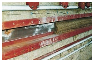
4. Minerale wol inbrengen
