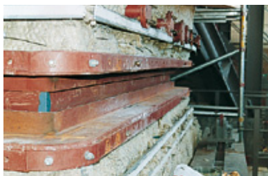
1. Ocelová konstrukce bez kompenzátoru. Pozor: Před začátkem montáže přezkontrolujte rozměry!
