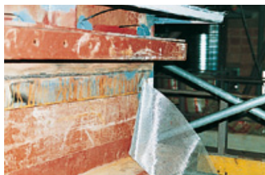
2. Na obou stranách upravte drátěné pletivo z V4A ...
