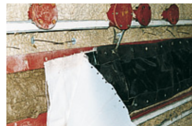
6. Namontujte kompenzátor z měkkého materiálu a následně slepte oblast spojení podle návodu k lepení (viz piktogramy).
